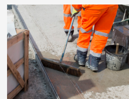
Die Unterseite der Pflastersteine gründlich reinigen.
