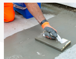
Mit einem Pinsel / einer Bürste eine 1 - 2 mm dicke Schicht auf den Pflasterstein auftragen.
